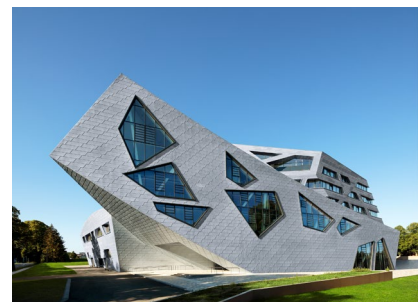
Klempnertechnische Meisterleistung – gleichmäßige und umlaufende Rasterung der Fassadenrauten
