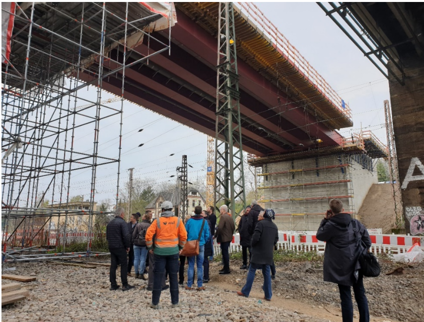
Bildunterschrift: Bau der Lohring-Brücke in Bochum - Baubesichtigung (Dateiname: 2023_izink_baubesichtigung_lohring-bruecke_bochum) Bildquelle: Initiative ZINK
